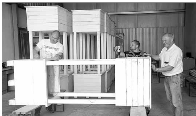
v. l.: Ronny Meiling, Patrick Lohmann und Projektbetreuer Mario Mannchen bei Reparaturarbeiten an den Wegweisern.
