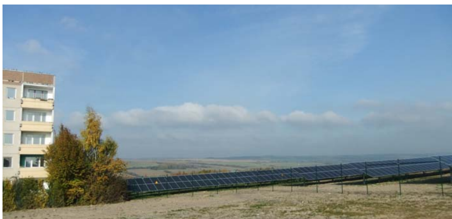
Photovoltaikanlage am Othaler Weg
