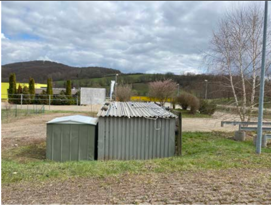
Funktionsgebäude im Bereich Flurstück 134/2 LSG
